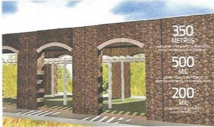
Una imagen digital permite apreciar la consolidación de los muros de piedra y una estructura nueva en el interior de la ermita.
